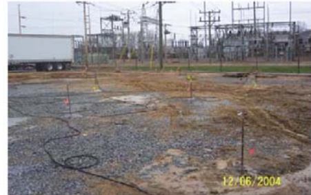
Poços de Injeção no Sítio
