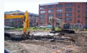
Mistura de solo com Klozur™ e cal hidratada
